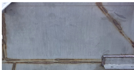
powierzchnia przed obróbką
